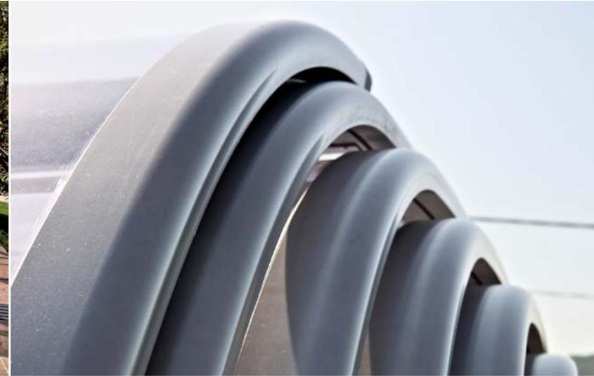
DER EINSATZ VON MODERNEN, COMPUTERGESTEUERTEN BIEGEANLAGEN ERMÖGLICHT DIE MASSGENAUE ANFERTIGUNG VON WECHSELNDEN BÖGEN BEI DEN ÜBERDACHUNGEN. DIE ÜBERDACHUNGEN MIT KORBBÖGENFORM HABEN DURCH DIE VORTEILHAFTEN STATISCHEN EIGENSCHAFTEN DER GEBOGENEN STRUKTUREN MIT SCHWUNGVOLLEN FORMEN, DIE AUSWAHL BEREICHERT.
